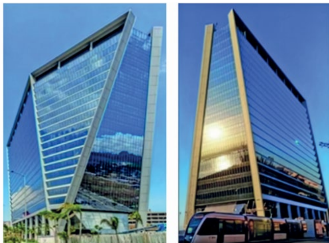
Figura 3. Fachadas do Edifício Aqwa Corporate, Rio de Janeiro
