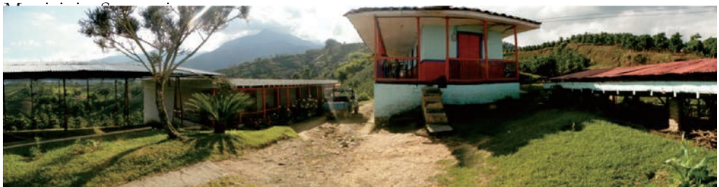
Figura 69. Casa cuartel y leñadero de la finca La Primavera
