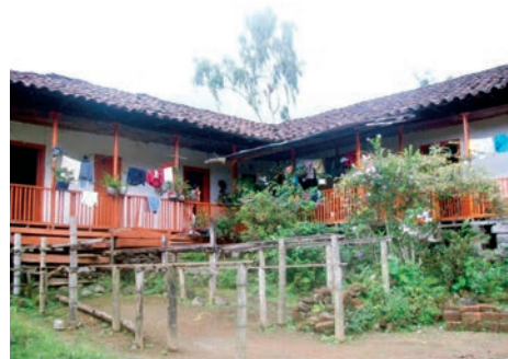
Figura 121. Casa de finca San José
