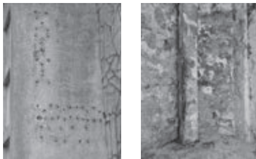
Imágenes 337 y 338. Detalles substracción de tipografía y humedad en la cubierta mausoleo P49-1. Fuente: Alfonso Javier López M.
