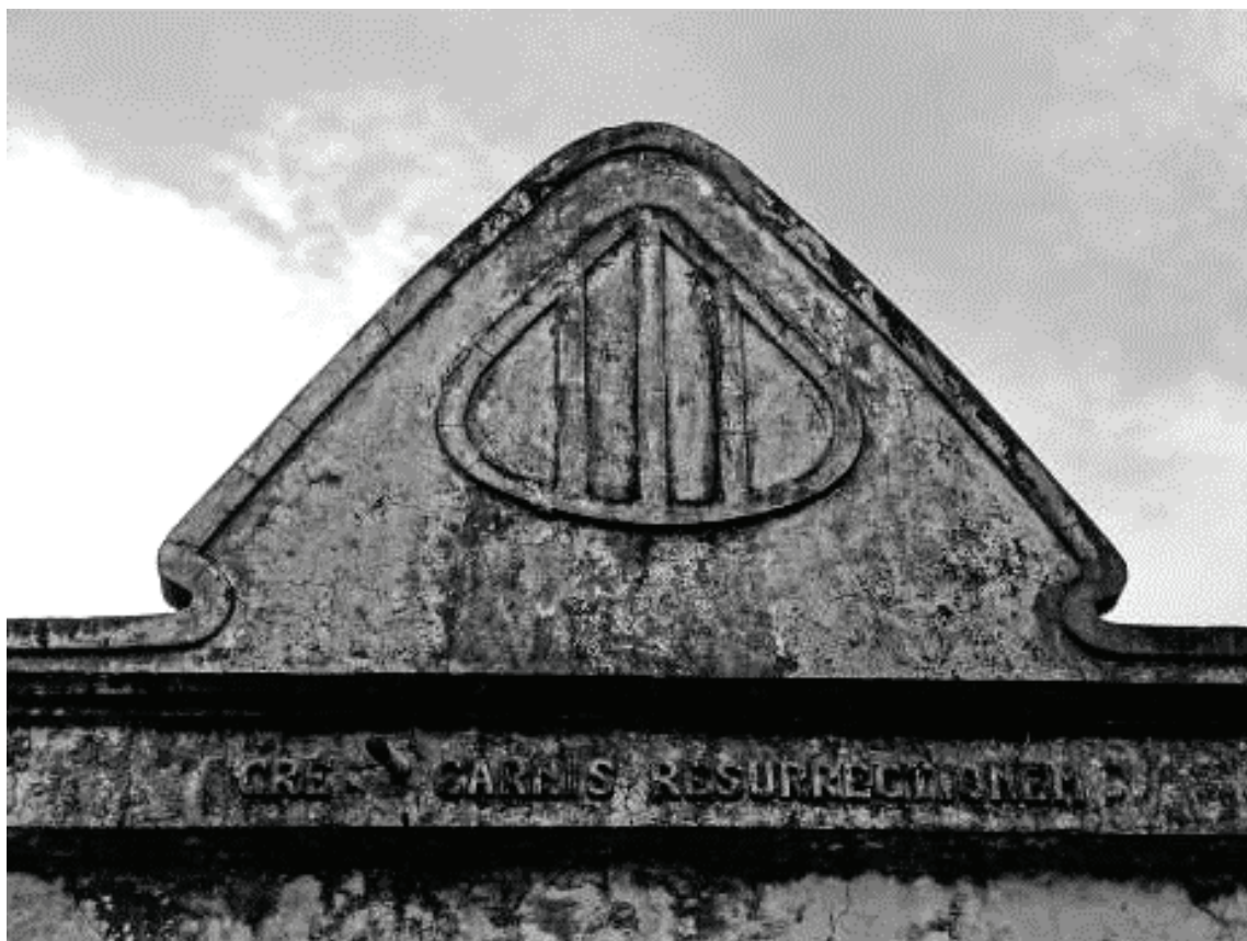
Imagen 55. Detalle de aviso a la entrada de la galería central por la calle 31.GA central Fuente: Alfonso Javier López M.
