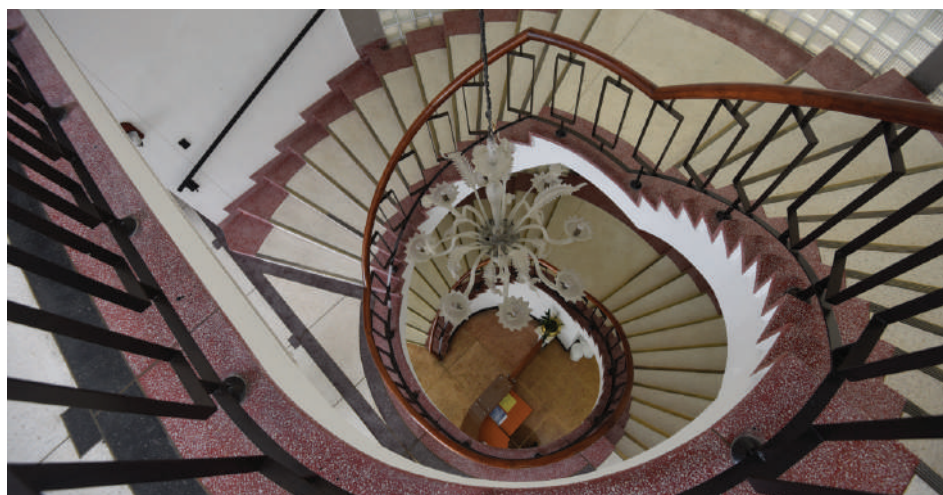
Escalera en caracol al interior de la sede Curia Episcopal de la Diócesis de Pereira
