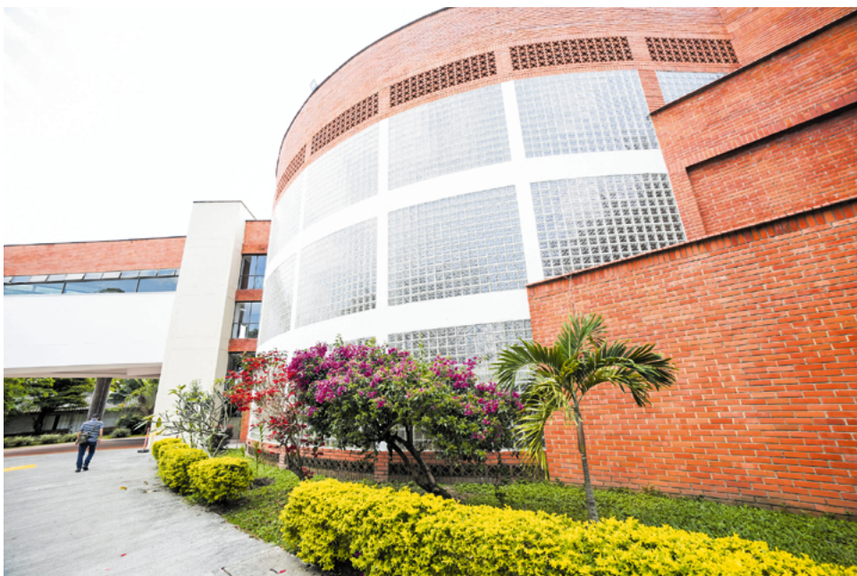
Exterior Biblioteca Cardenal Darío Castrillón Hoyos
