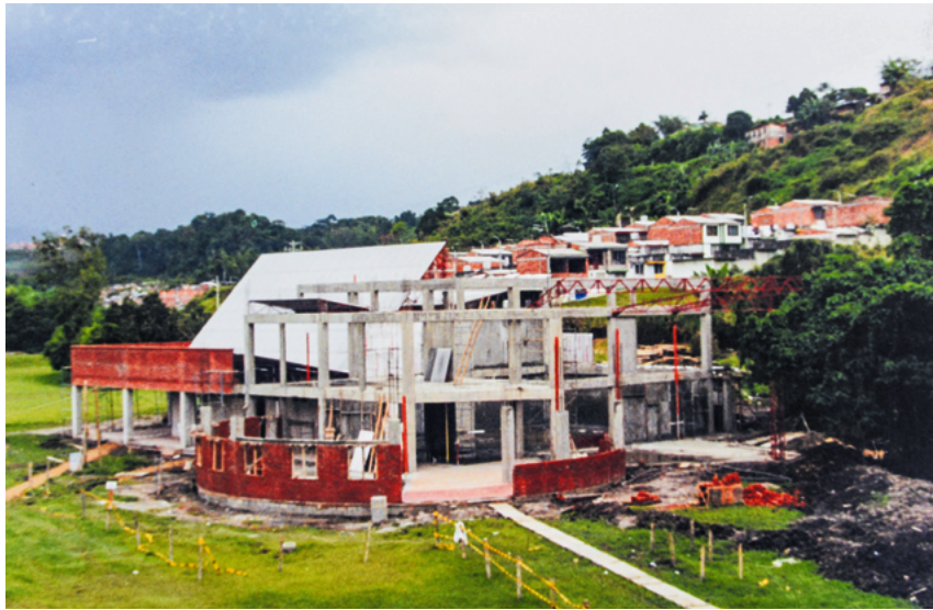
Construcción del bloque Buena Nueva
