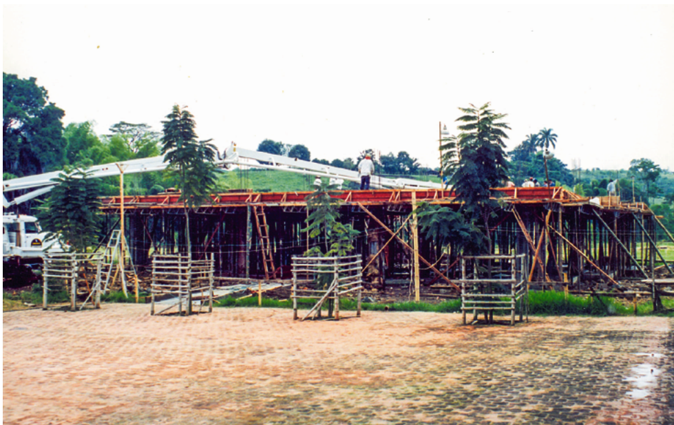
Construcción del bloque Humanitas
