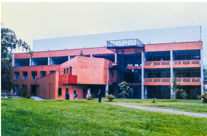
Construcción del bloque Kabai
