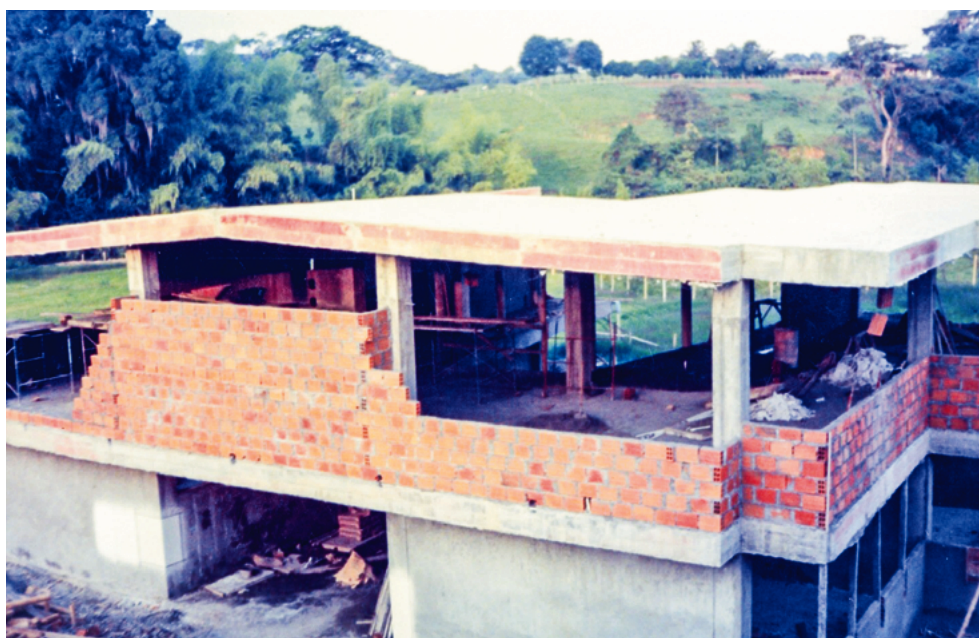
Construcción del bloque Humanitas
