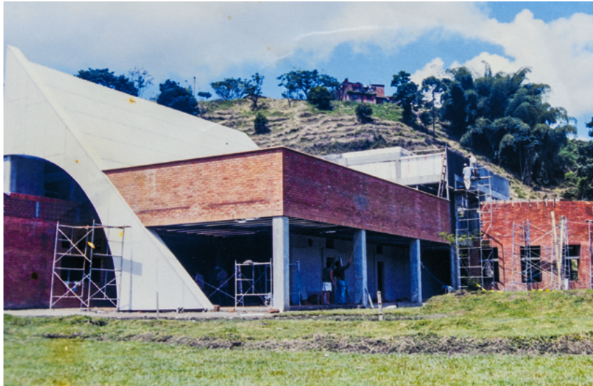
Construcción del bloque Buena Nueva
