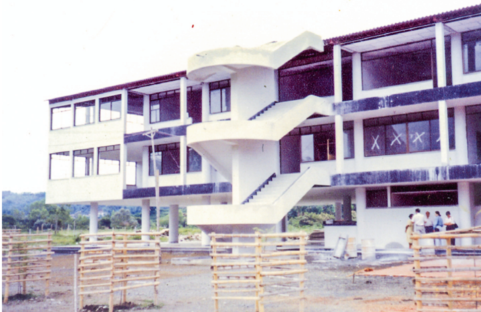
Construcción del bloque Aletheia
