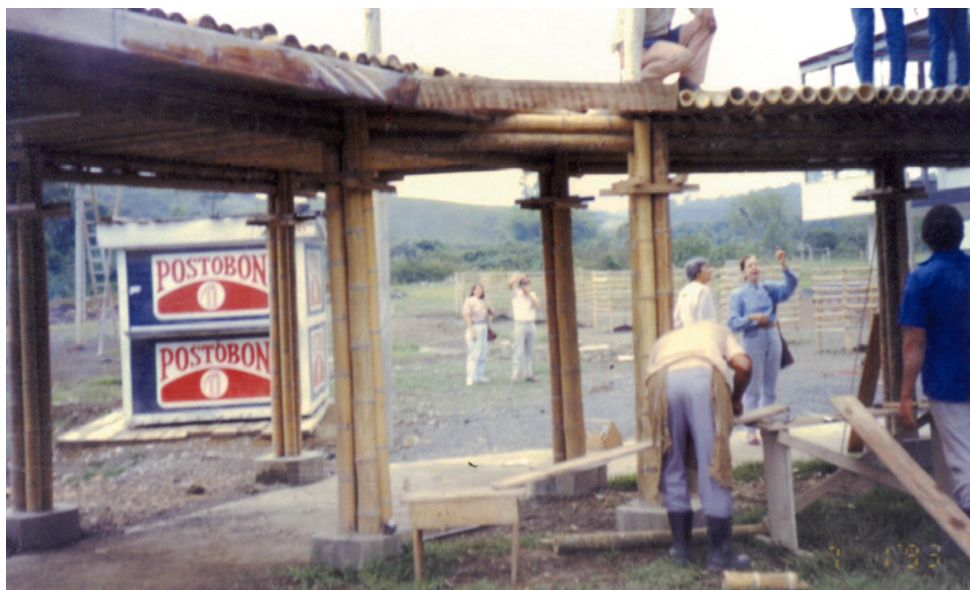
Construcción de la pérgola
