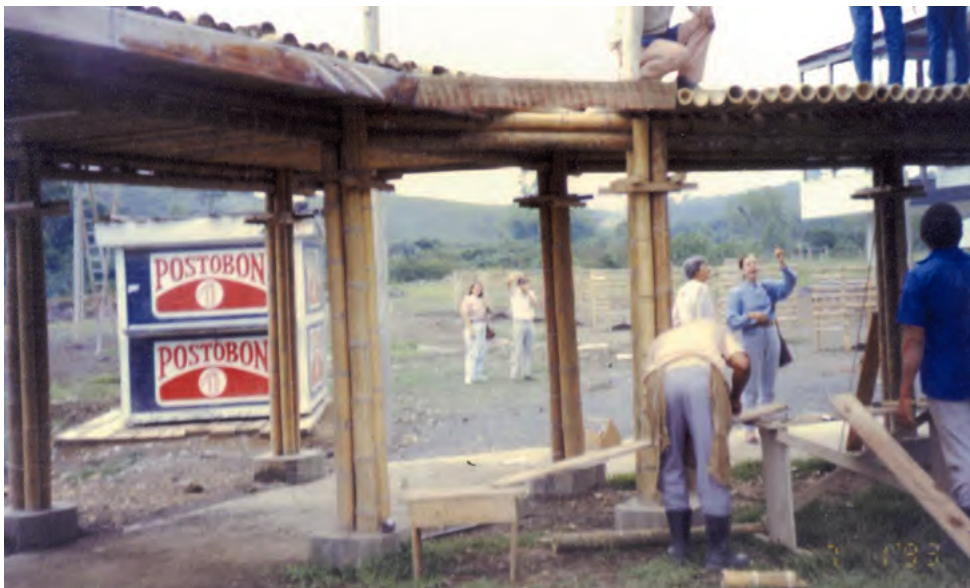
Construcción de la pérgola
