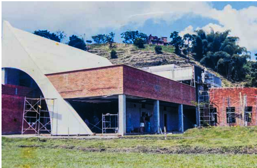
Construcción del bloque Buena Nueva
