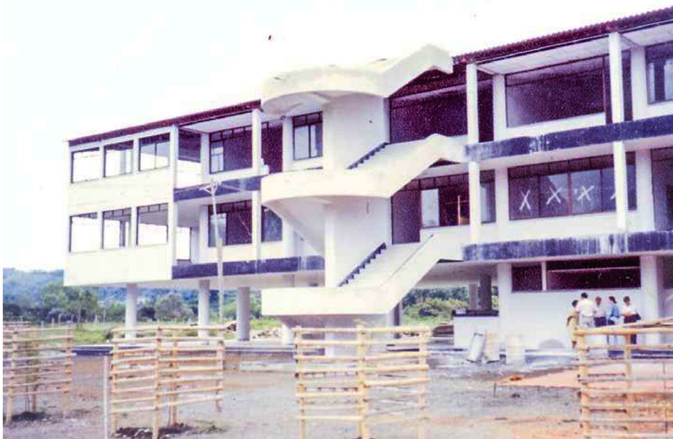
Construcción del bloque Aletheia
