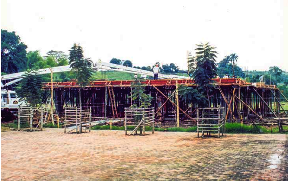
Construcción del bloque Humanitas
