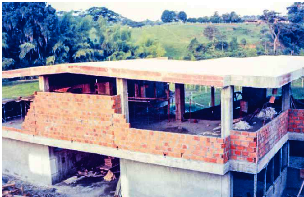
Construcción del bloque Humanitas
