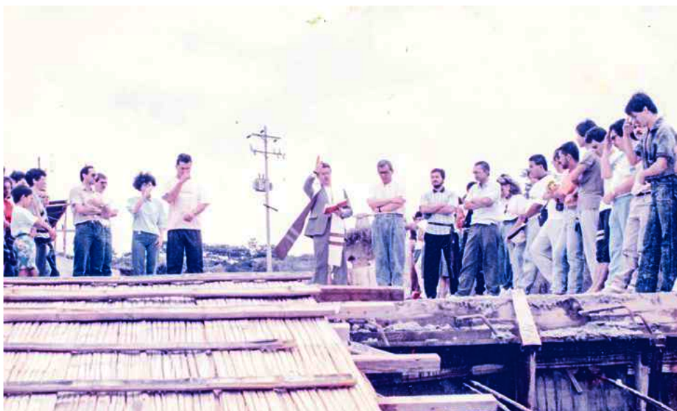
Bendición del puente por Monseñor Francisco Arias Salazar
