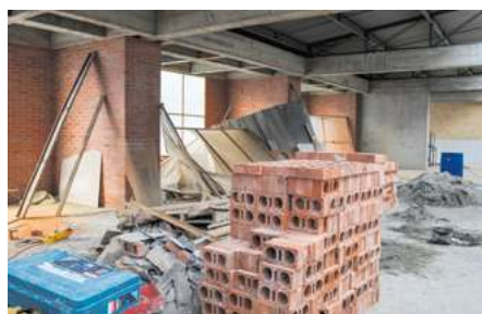
Continuación de construcción de bloques Kabai y Buena Nueva
