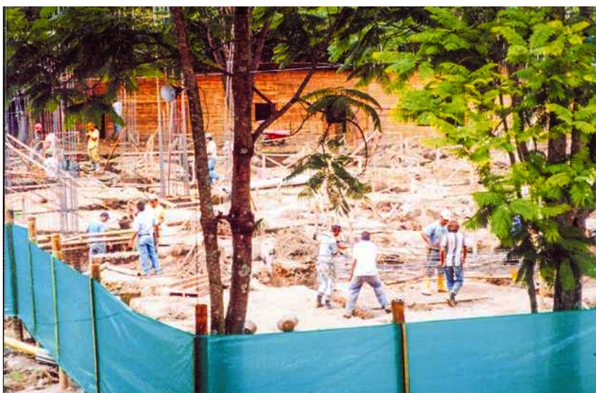
Construcción de la Biblioteca Cardenal Dario Castrillón Hoyos
