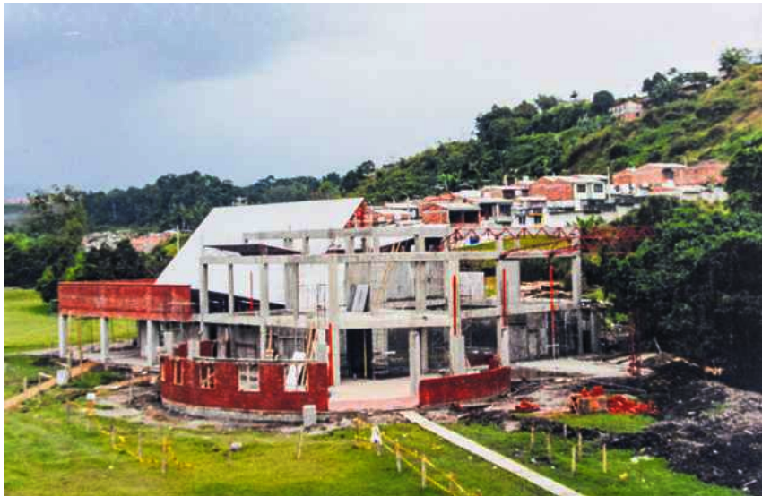
Construcción del bloque Buena Nueva
