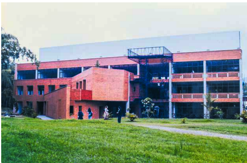
Construcción del bloque Kabai
